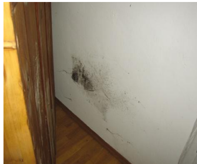
Plaatselijke koudebruggen (condensvorming) (fouten in het metselwerk)
