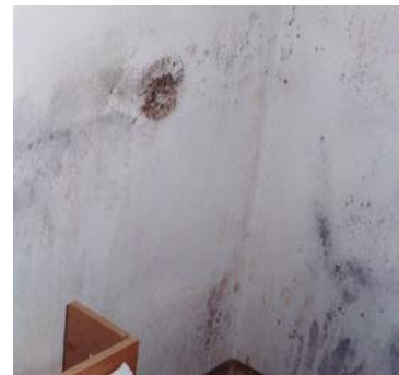
Plaatselijke en algehele koudebruggen (condensvorming)
