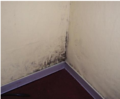
Koudebruggen (condensvorming) in de hoeken met schimmelaantasting
